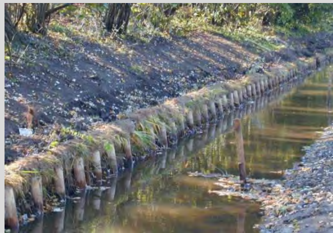
Photo 93 : Exemple d'installation des fascines par maintien par pieux (Source : AquaTerra Solution)
